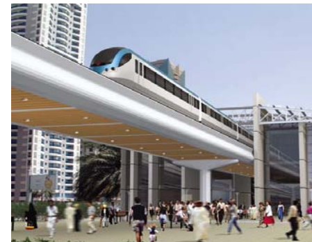
ドバイLRT(新交通システム) 向け受変電設備 [UAE]
