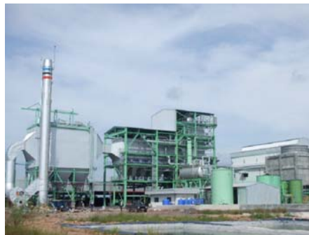
バイオマス発電プラント [タイ、マレーシア]
