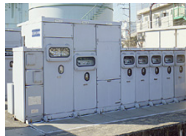
固体絶縁開閉装置
