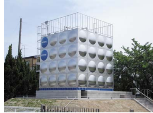
自家用水道システム (WATERCUBE)
