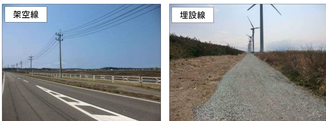
図 2.2.6-7 既設送電線の設置状況
