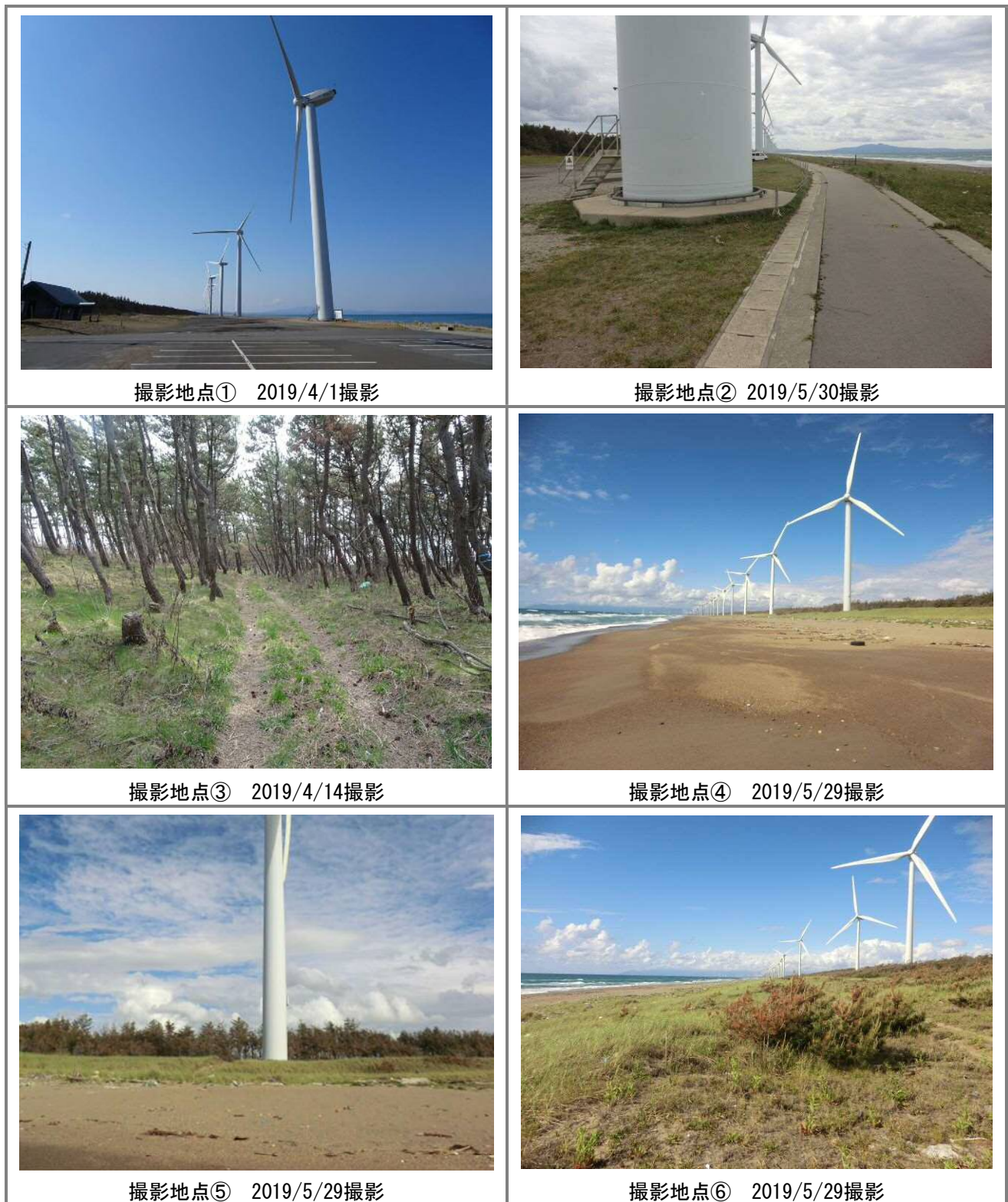
図 2. 2. 4-5 対象事業実施区域の状況
