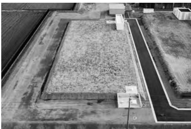
第11図 東部浄水場浄水池増設工事の施工事例
