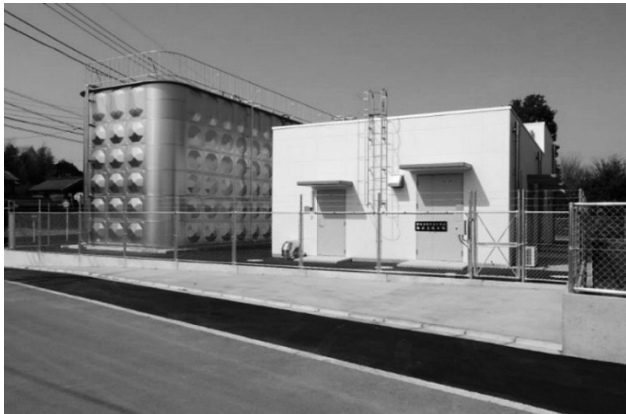
第10図 板倉北浄水場配水設備工事の施工事例
