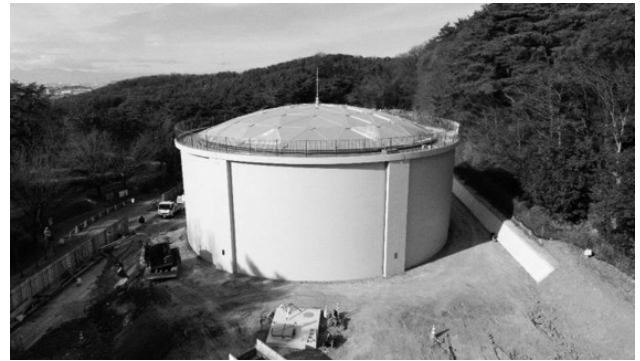
第12図 太田金山配水池No.1配水池更新工事の施工事例
