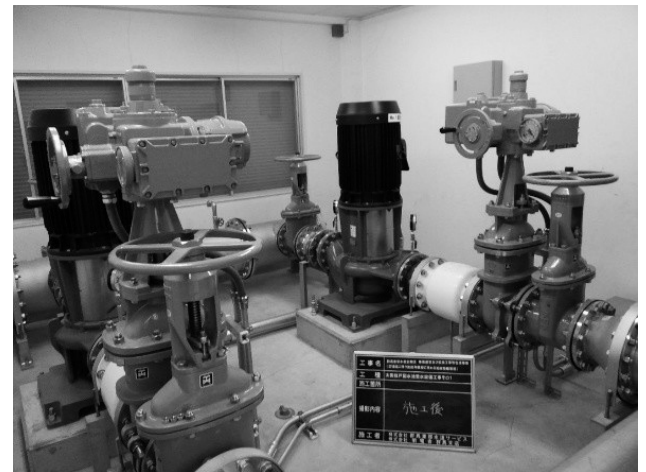
第8図 太田強戸配水池受水設備工事の施工事例
