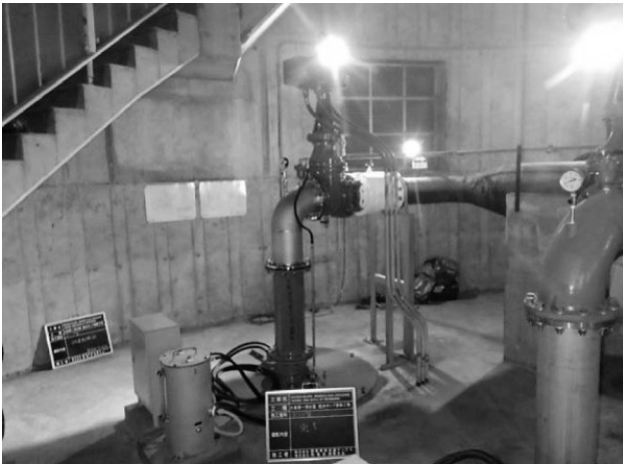
第7図 大泉第一配水場配水ポンプの施工事例
