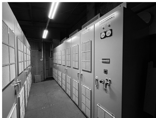
第1図 IDF用高圧インバータ盤
