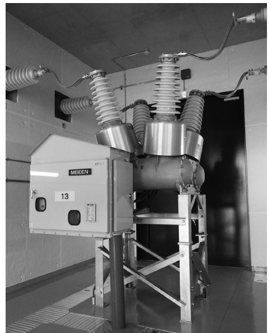
第 5 図 き電用遮断器
