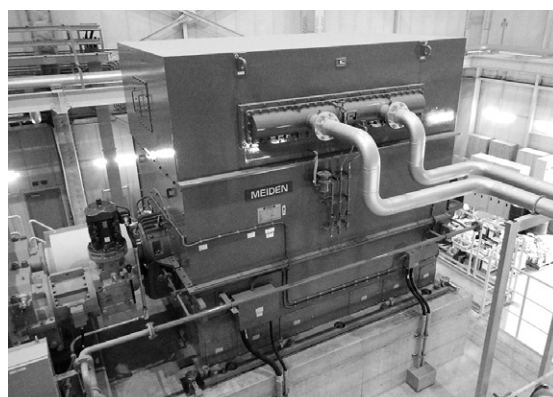
第8図 4極蒸気タービン発電機
