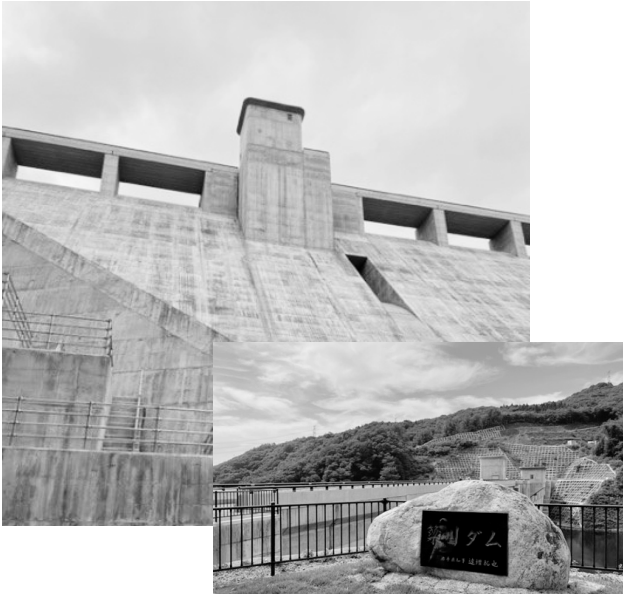
第1図 築川ダム
