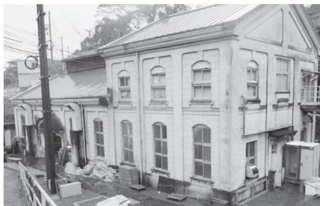
第1図 旭発電所
