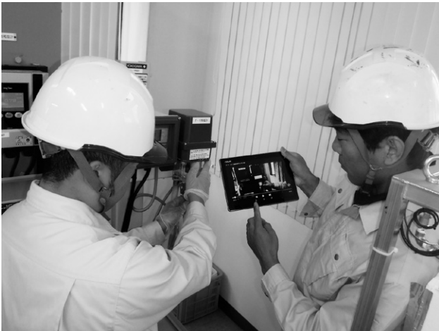
第9図 点検方法の動画を参照した点検巡視の様子
