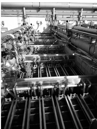
第5図 チェスナッツアベニュー浄水場 セラミック平膜ろ過設備
