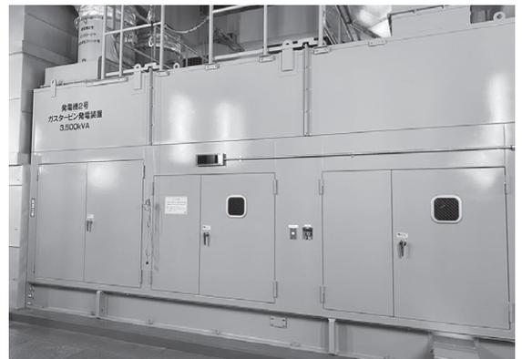
第5図 3500kVAガスタービン発電機
