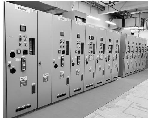
第4図 22kV GIS ハイクラッド HICLAD-20GB
