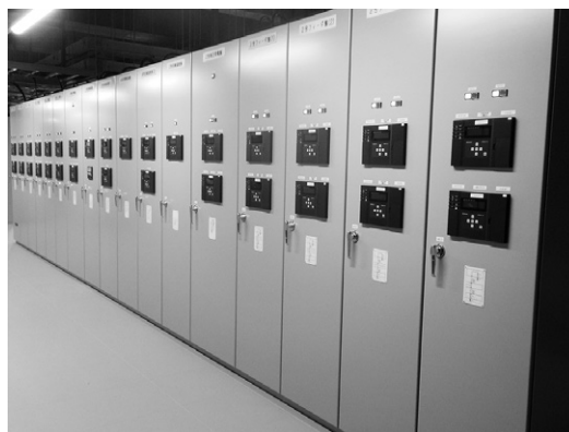
第3図 高圧盤(H-AIS)
