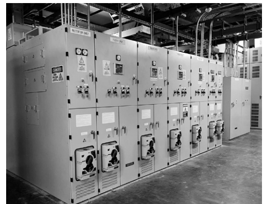
第5図 1500V直流き電盤
