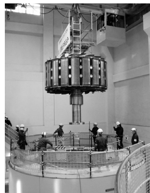
第5図 2号水車発電機の回転子つり込み状況
