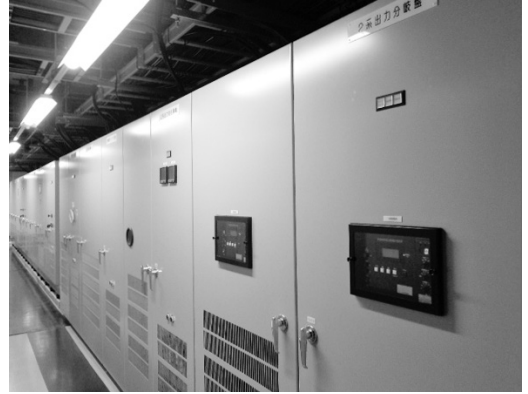
第1図 無停電電源装置周辺盤
