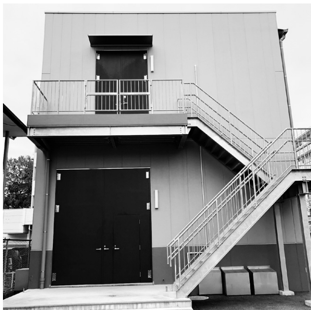
第2図 変電所全景
