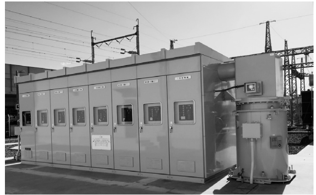
第 9 図 72kV屋外形C-GIS
