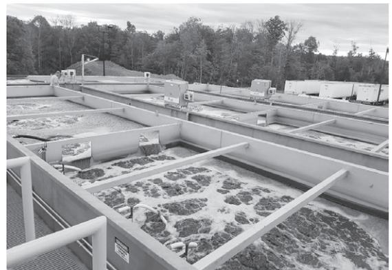
第6図 セラミック平膜を用いた排水処理設備
