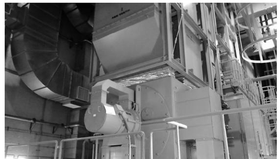
第3図 非常用発電装置 (6.3kV 23MW)
