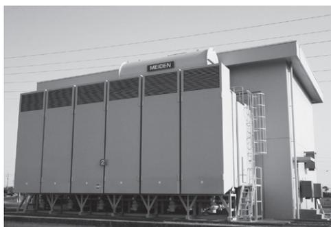
275kV 500MVA負荷時タップ切換変圧器
