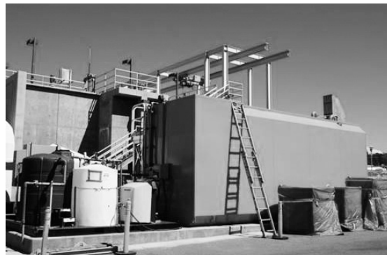
第7図 セラミック平膜MBRパイロットプラント(処理規模120m 3 /日)
