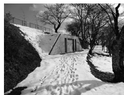
(b) 古館城山配水池 入口
