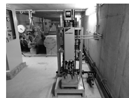
(d) 古館城山配水池 管廊
