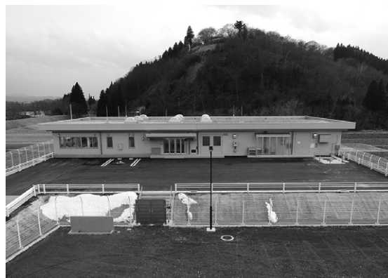
第8図 古館浄水場全景
