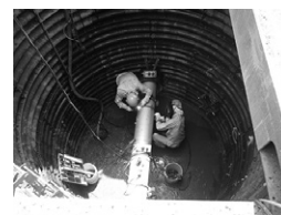
(c) 送水管 推進施工状況
