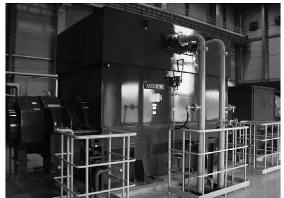
第14図 4極突極タービン発電機
