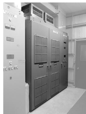
第3図 押出機用高圧インバータ
