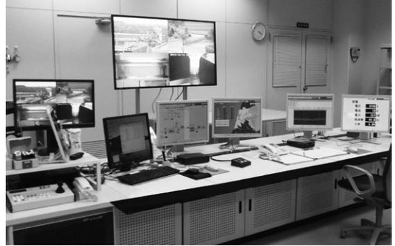
第 1 図 LCD監視制御装置
