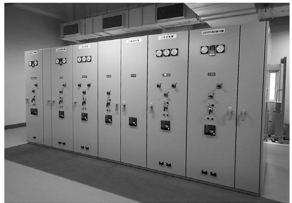
第8図 ドライエア絶縁開閉装置
