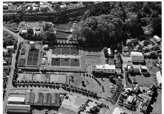
第10図 西川浄水場全景
