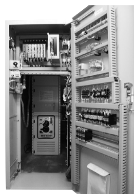
第2図 直流き電盤
