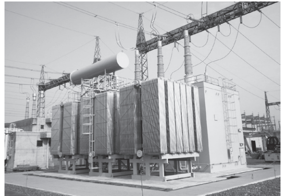
第4図 ルーフデルタ変圧器
