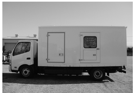
第9図 6/3kV切り替え式高圧発電機車
