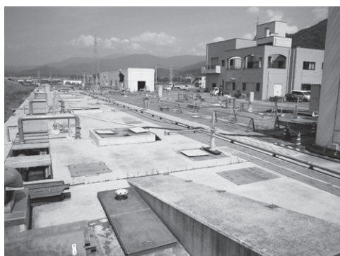
復旧中の大船渡浄化センター
