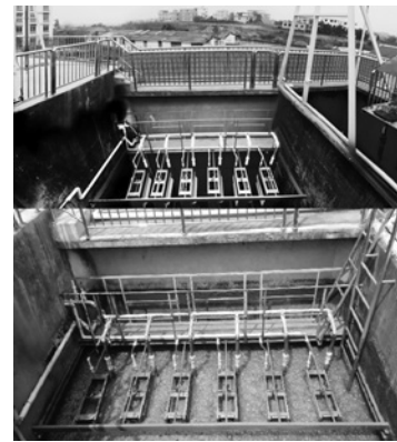
第10図 中国桂林理工大学雁山キャンパス内の膜処理設備
