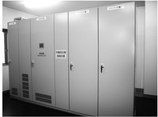
第4図 キャパシタ瞬低補償装置
