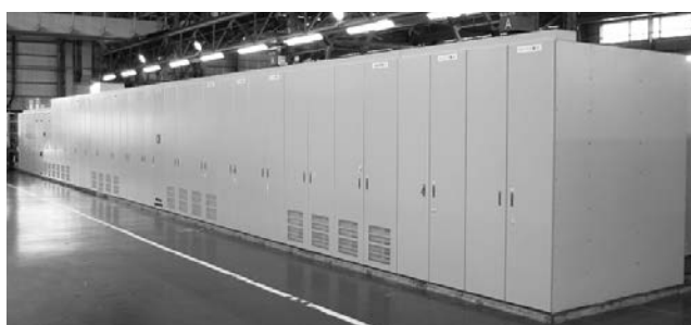
第6図 電気二重層キャパシタ適用瞬低補償装置
