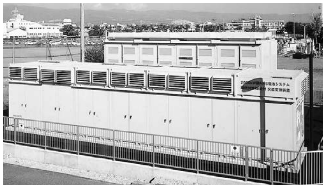
第5図 瞬低補償機能付きNAS電池用PCS
