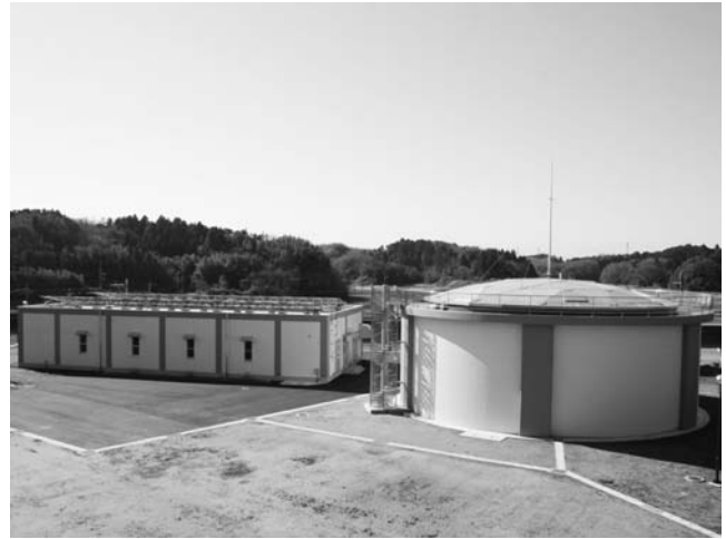
第5図 配水場全景
