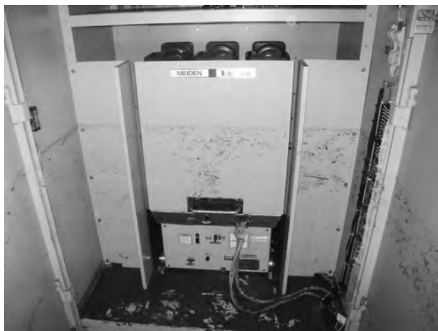
第5図 22kV配電盤内部 配電盤内部の真空遮断器は、海水が浸入したため動作が不可能である。
