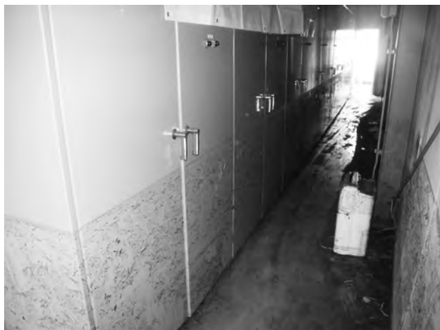
第4図 22kV配電盤 汚れによって海水の浸入跡がうかがえる。
