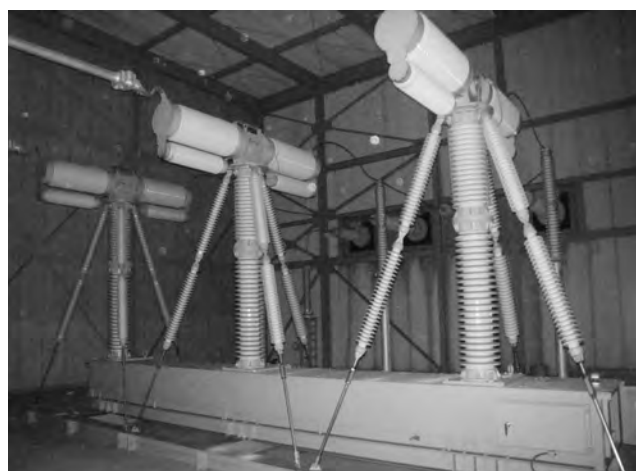
第3図 168kV真空遮断器 操作機構部においても特に被害はない。
