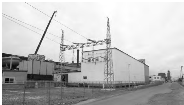
第7図 復旧した受電所
