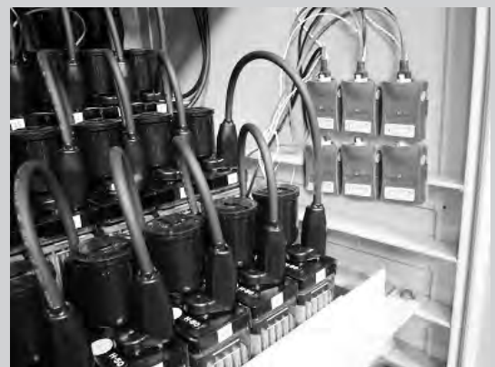
鉛バッテリー劣化監視システム ESW-100B
