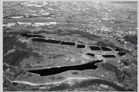
米倉山太陽光発電所全景
