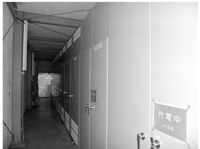
第11図 22kV配電盤
