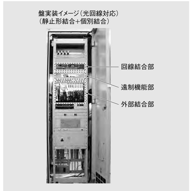
第2図 電鉄用IP遠制装置 盤実装イメージ IP遠制装置のイメージを示す。大きく「回線結合部」、「遠制機能部」、「外部結合部」に分かれる。
