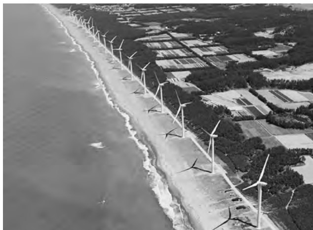
第6図 八竜ウインドファーム全体図 八竜ウインドファームは1.5MW級風力発電機MD-77を17基設置。2基の風力発電機でMEICAPの適用試験を行っている。
