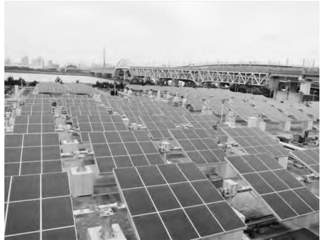
第10図 一軸追尾タイプ太陽光発電設備
