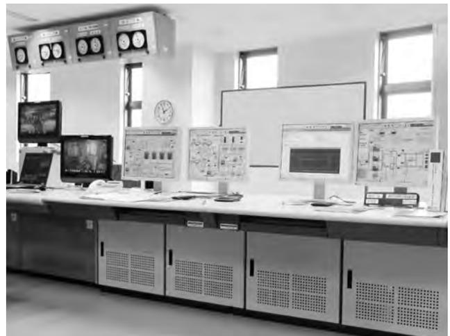
第13図 LCD監視制御装置
