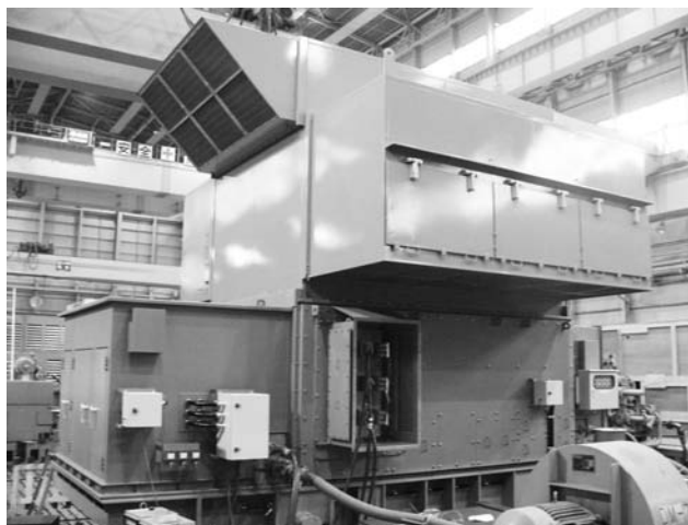
第10図 沿岸地域用屋外開放形発電機 塩害防止フィルタを適用した2極発電機の外観を示す。
