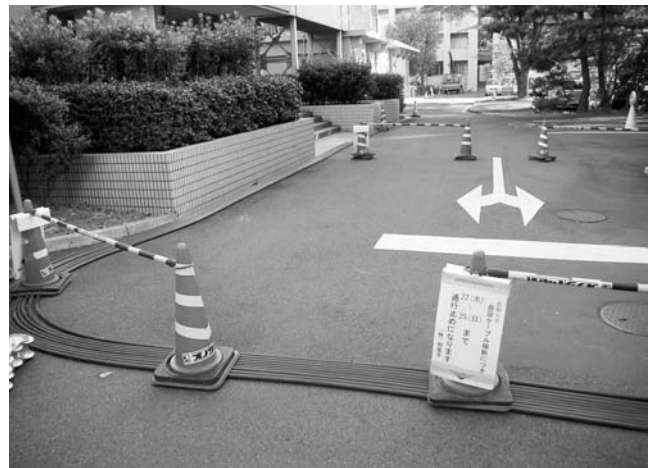
第7図 仮設ケーブル布設状況 停電時の負荷救済に必要な仮設ケーブルの布設状況を示す。
