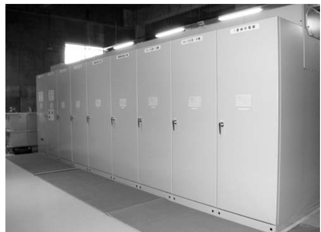
第2図 72kVガス絶縁開閉装置
