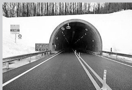
新佐呂間トンネル佐呂間側坑口
