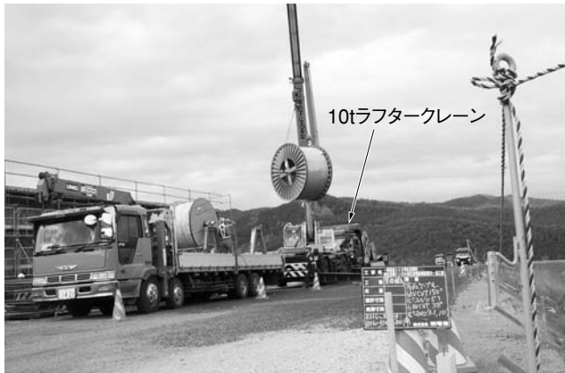
第6図 ケーブルドラムの搬入状況 ケーブルドラム搬入専用10tラフタークレーンを手配した。
