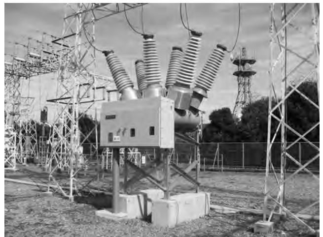
第18図 エコ・タンク形真空遮断器
