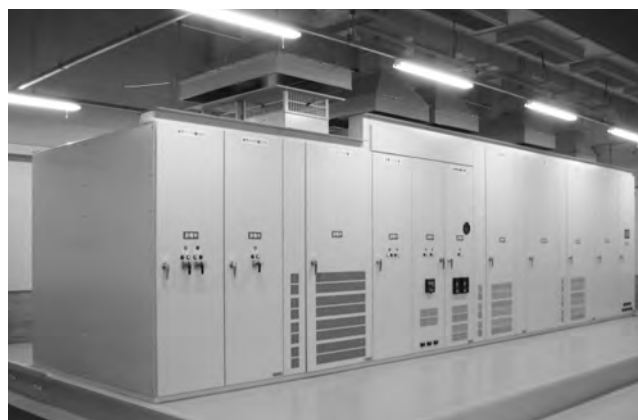
第23図 電気二重層キャパシタ式瞬低補償装置
