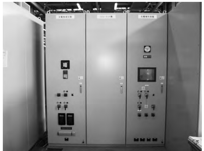
第5図 全機能一体形制御保護装置
