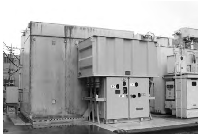
第8図 ガス絶縁SPC開閉器（G-SPC）
