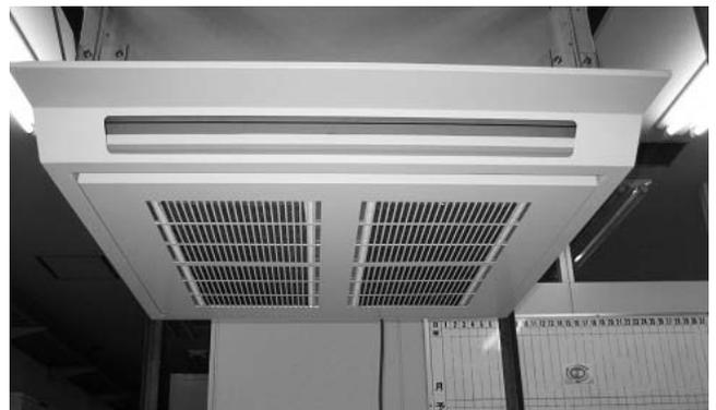
第11図 天井取付け脱臭装置
