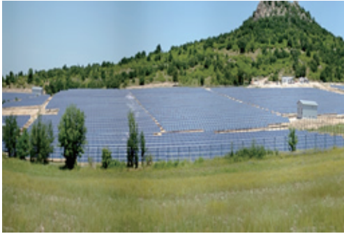
▲ブルガリアで建設中の太陽光発電所（合計25MW予定）
