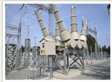
▲世界最高電圧クラスのタンク型真空遮断器（VCB）
