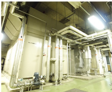
▲発電時の熱エネルギーも活用できるコージェネレーションシステム
