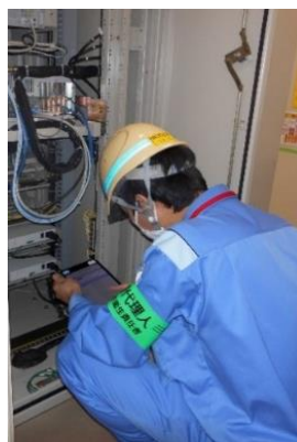
タブレット端末を使用した作業の様子
