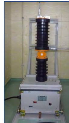
切替遮断器 (新幹線が通過する度に、 入り切りする)
