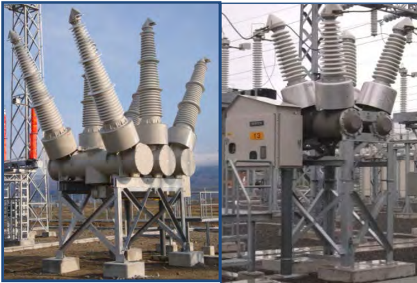
真空遮断器 毎日1回の開閉に耐えられる (多頻度真空遮断器:寿命 1万回)
