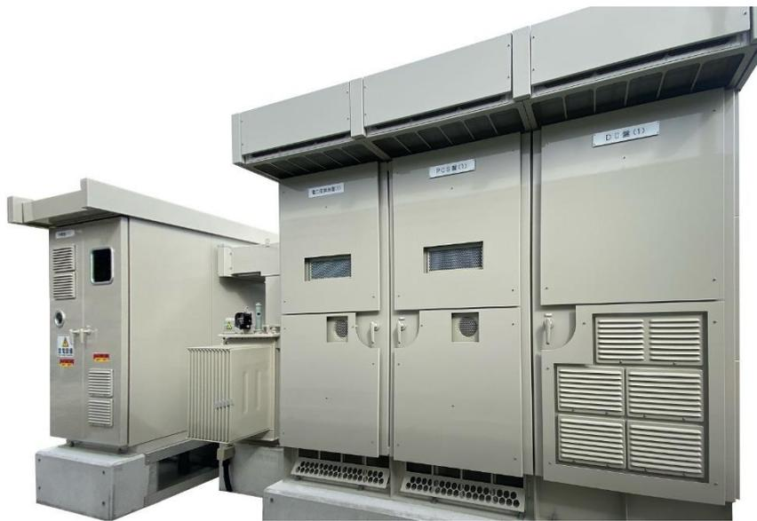
リチウムイオン電池用交直変換装置（PCS）
