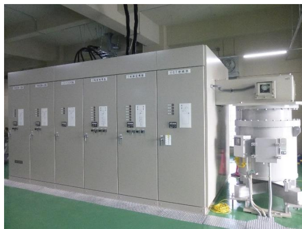
ガス絶縁開閉装置
