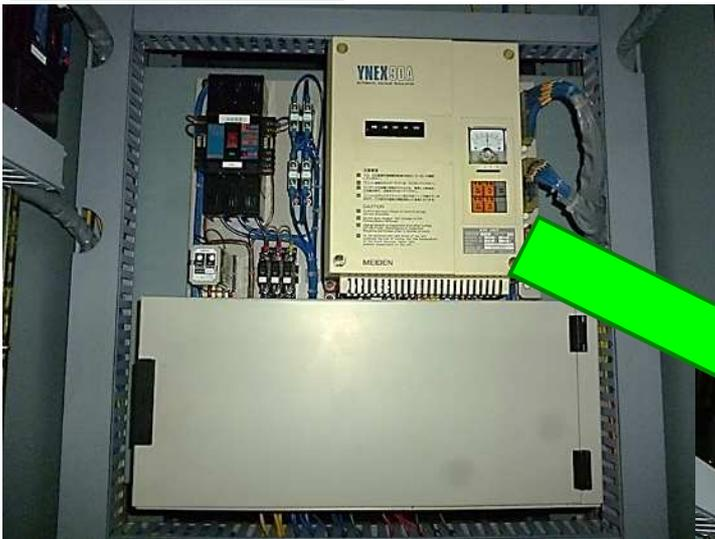
左写真に搭載されているAVR（YNEX90A）は現在製造中止製品となっています。
